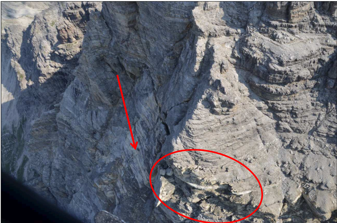
Foto 1: Die Zerlegung im Bereich der nordwestlichen Flanke schreitet deutlich fort (rote Ellipse). Große Blöcke können hier jederzeit abstürzen. Mit rotem Pfeil markiert jene Stelle, wo ein markanter Felsturm abgestürzt ist.
