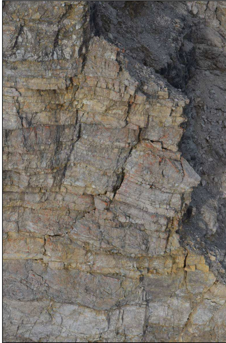
Foto 5: Ausschnitt aus der Ost- bzw. Südwand. Deutlich erkennbar die Zerlegung bzw. frische Spaltenbildung und dadurch bedingte Bildung von Felstürmen samt Vorbereitung des Absturzes teils ausgedehnter Wandpartien.
